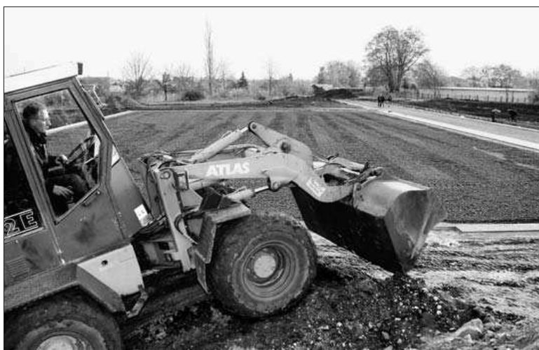
Noch führen die Bagger Regie auf dem neuen Sportplatz des Norbertusgymnasiums an der Nachtweide. Im April 2011 soll das Gelände dem Schulsport zur Verfügung stehen. Fotos (2): Oliver Schlicht
